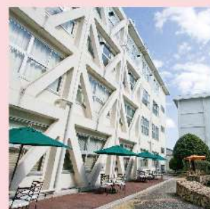
耐震化された校舎
