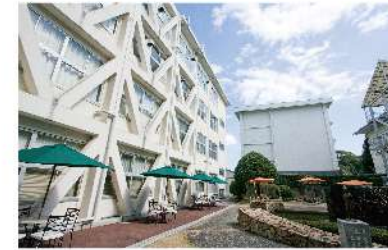
耐震補強された学舎
